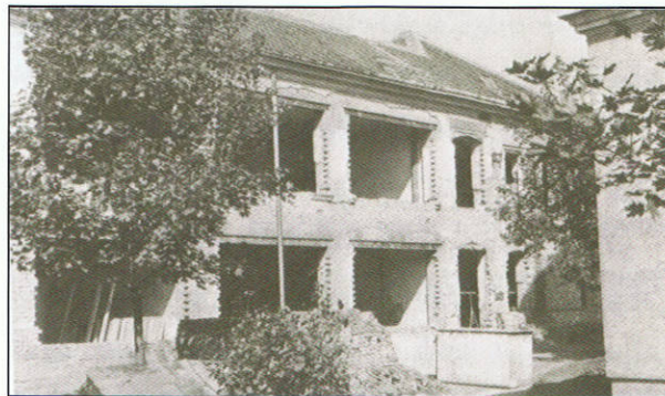
Die Schule während des Umbaus
